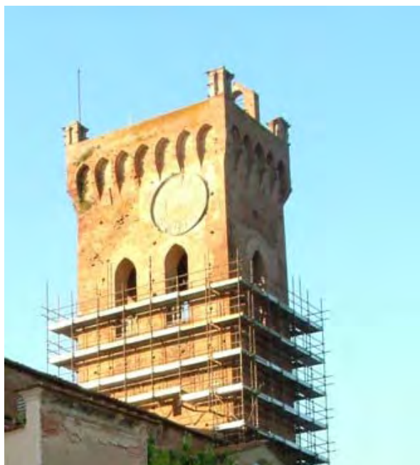
▲ [Luglio 2010] L'inizio dei lavori di restauro del campanile della Cattedrale.
